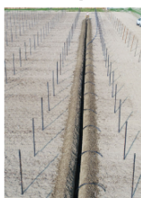
Realizzazione di un impianto a goccia
