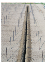
Realizzazione di un impianto a goccia
