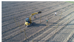
Interramento pali in legno
