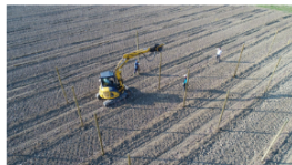
Interramento pali in legno
