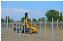
Interramento pali vigneto
