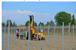
Interramento pali vigneto
