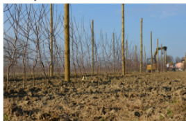
Interramento pali in legno dopo la messa a dimora delle piante
